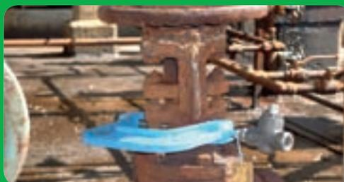
Pose d'un serre à vis et injection
