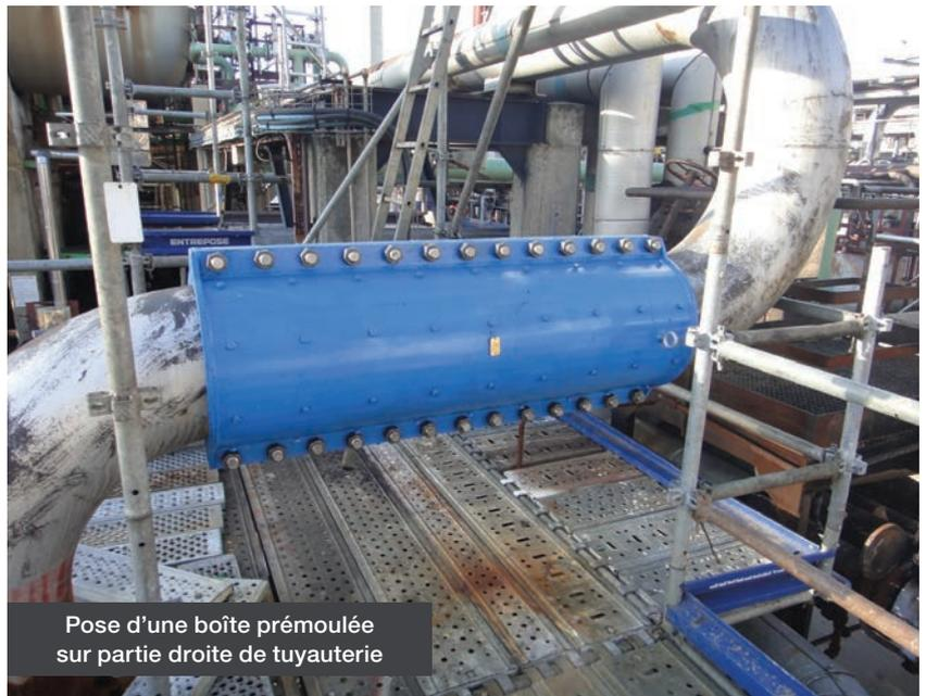
Pose d'une boîte prémoulée sur partie droite de tuyauterie
