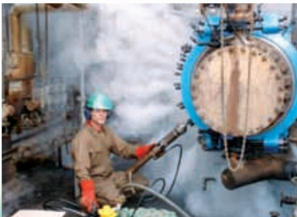
Intervention sur tuyauterie droite, coudée, sur piquage ou appareils divers (corps de vanne, clapets...)
